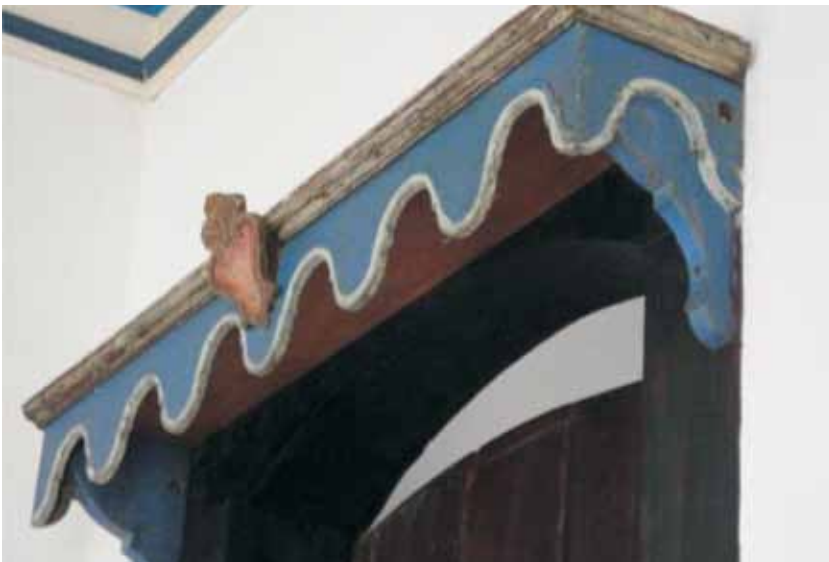
Figura 3c – Detalhe do lambrequim depois da restauração
