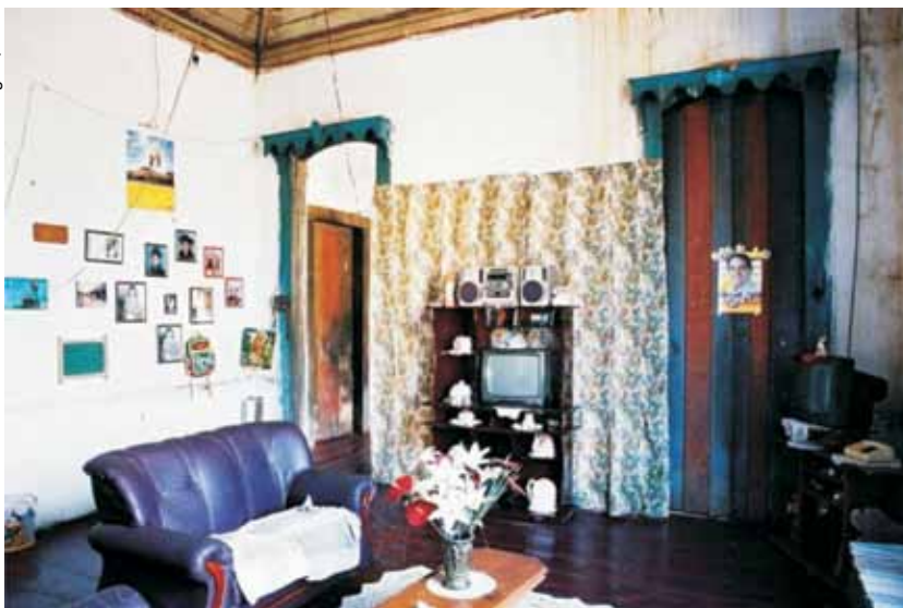
Figura 3 – Portas com lambrequim antes da restauração
