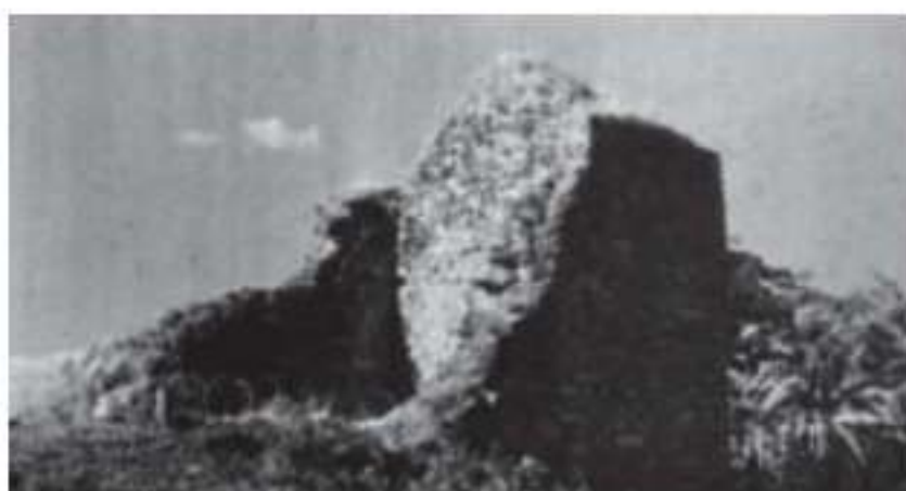
Fig. 42 – Ruínas da Igreja de N. S. do Rosário do antigo Arraial de Traitas.
