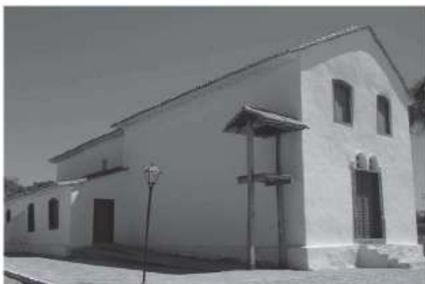
Fig. 33 – Imagem da Igreja do antigo Arraial de Jacuá.
