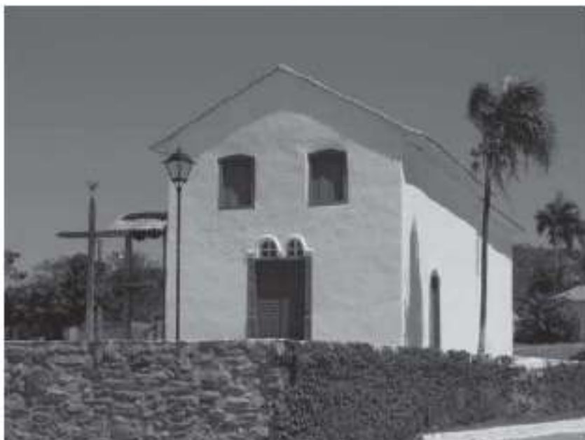
Fig. 31 – Imagem da Igreja do antigo Arraial de Jacuá.
