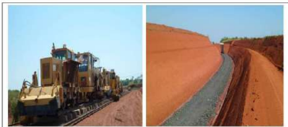
Figura 14 – Construção da FNS em Goiás: extensão sul
